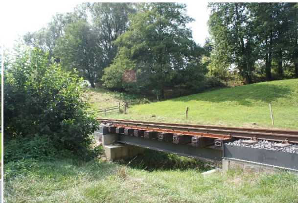
Brücke Schmalspurbahn Lohsdorf
