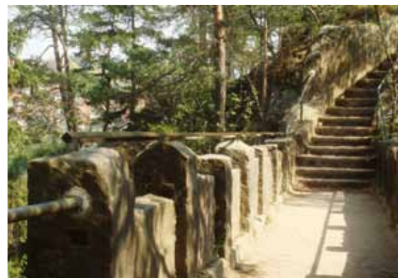
Neue Geländer an der Teufelsbrücke am Hockstein
